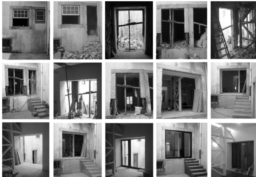
►►► Processo de obra_Reconstrução dos vãos aproveitando as cantarias originais
